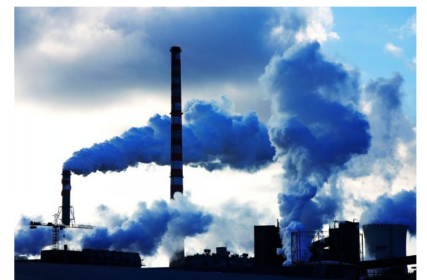
Rejet dans l'atmosphère
